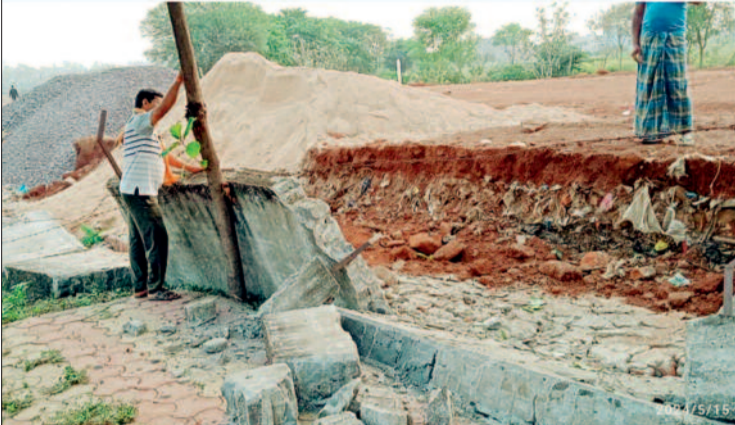
मुक्तिधाम की चारदीवारी से लगकर पीडब्ल्यूडी द्वारा इंजीनियरिंग पार्क के लिए सड़क बनाया जा रहा है। सड़क निर्माण के शुरुआती चरण में मृत्तम की परत बिछाए जाने से मुक्तिधाम की चारदीवारी की नींव गहराई में चली गई। सड़क पर बिछाए मृत्तम में पानी डालकर रोलर चलाने से मुक्तिधाम की चारदीवारी कमजोर हो गई। वहीं निगम के नाली निर्माण करने वाले टेकेदार ने भी चारदीवारी के किनारे गिट्टी व रेत का स्टक रख छोड़ा था। माना जा रहा है कि इससे दबाव बढ़ता गया और पुरानी चारदीवारी झसे झेल नहीं पाई और गिर गई।
